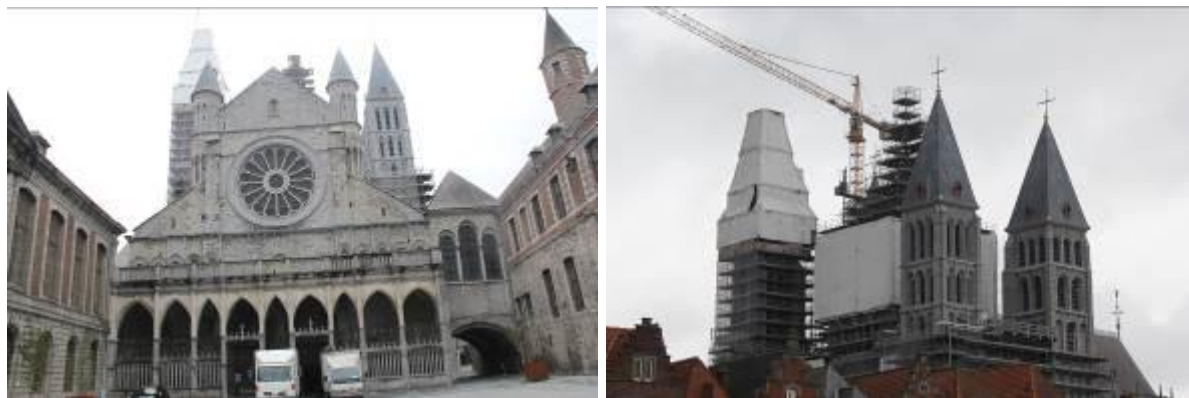
De O.L.V Kathedraal van Doornik, deels in de steigers
